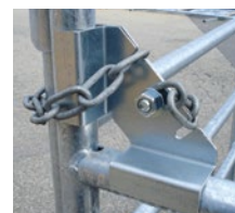
Stiftverbindung mit länglichen Schlitten, um sich dem Relief anzupassen
